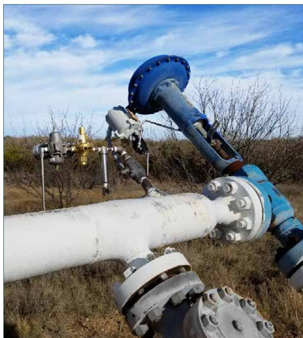
PAXi 天然ガスパイプラインのコントロールバルブ用圧力制御
